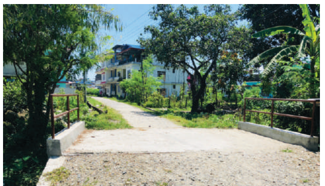
सुन्दरहरैँचा नगरपालिका वडा नं १० मा निर्माण गरिएको कल्भर्ट
