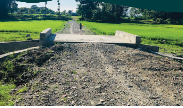
सुन्दरहरैँचा नगरपालिका वडा नं ११ मा निर्माण गरिएको कल्भर्ट
