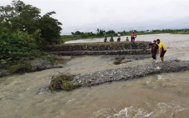
सुन्दरहरैँचा नगरपालिका वडा नं ४ मा गरिएको खोला तटबन्ध
