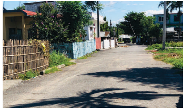
सुन्दरहरैँचा नगरपालिका वडा नं ४ मा निर्माण गरिएको कालोपत्रे (हवेलीमार्ग)
