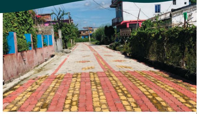
सुन्दरहरैँचा नगरपालिका वडा नं ४ मा निर्माण गरिएको नमुना मार्ग (पेवल्स)
