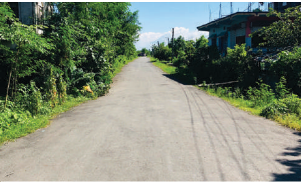
सुन्दरहरैँचा नगरपालिका वडा नं ४ मा निर्माण गरिएको कालोपत्रे (हवेलीमार्ग)
