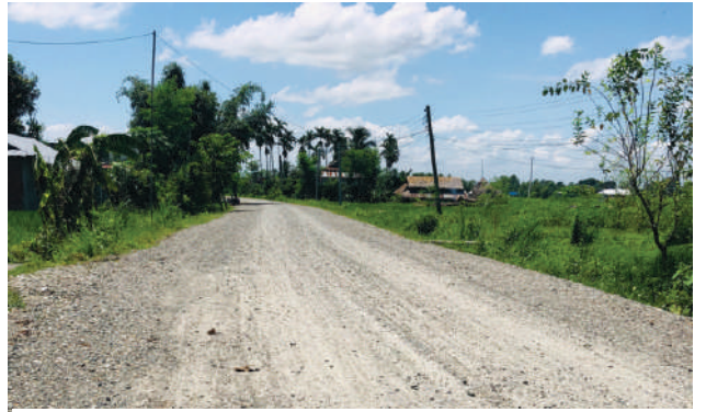
सुन्दरहरैँचा नगरपालिका वडा नं १२ मा गरिएको ग्राभेल(काफ्लेटेल दक्षीण)
