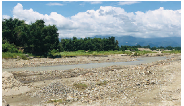
सुन्दरहरैँचा नगरपालिका वडा नं ०७मा गछिया खोलाको वर्तमान अवस्था
