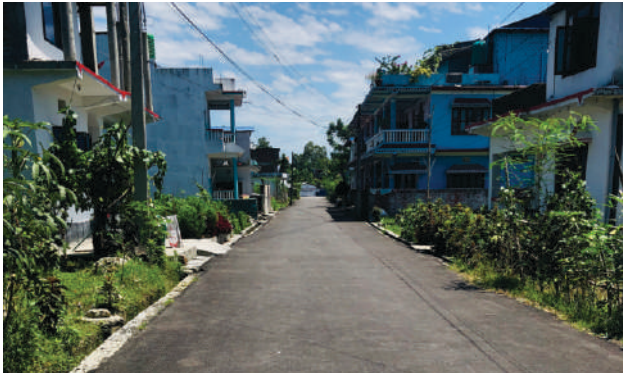
सुन्दरहरैँचा नगरपालिका वडा नं १२ मा निर्माण गरिएको नमुना मार्ग
