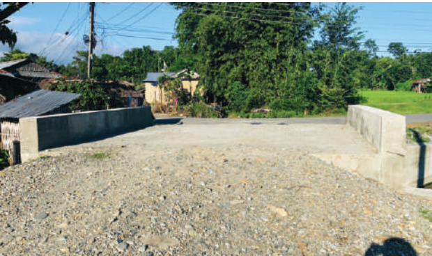
सुन्दरहरैँचा नगरपालिका वडा नं ०८ मा निर्माण गरिएको कल्भर्ट
