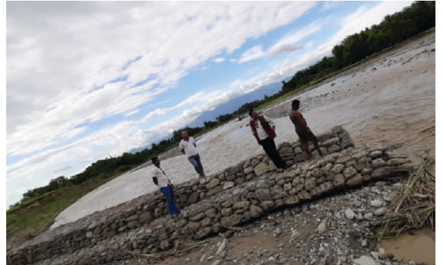
सुन्दरहरैँचा नगरपालिका वडा नं ४ मा गरिएको खोला तटबन्ध
